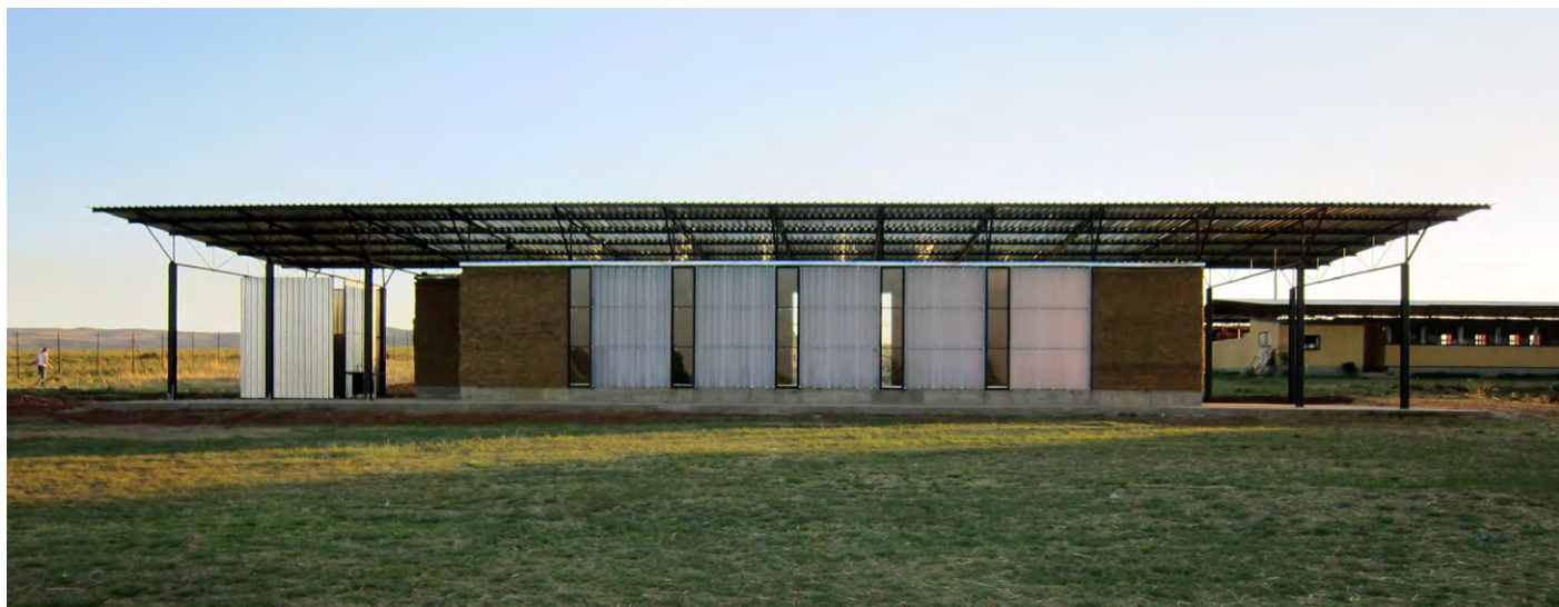
Slika 8: Večnamenska dvorana, 2011: pogled na zgrajeno stavbo s severne strani.
