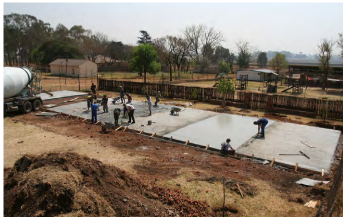
Slika 1: Knjižnica in učilnica, 2010: betoniranje talne plošče.
