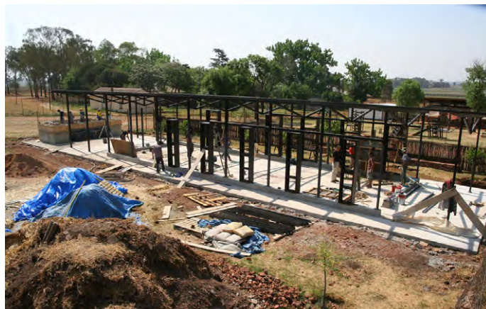
Slika 2: Knjižnica in učilnica, 2010: postavitev jeklene konstrukcije.
