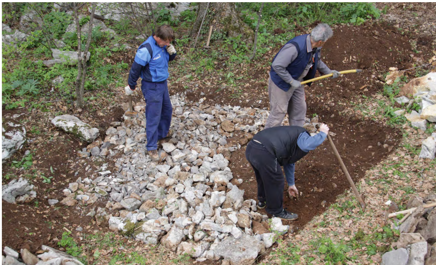
Slika 1: Priprava temelja hiške.
