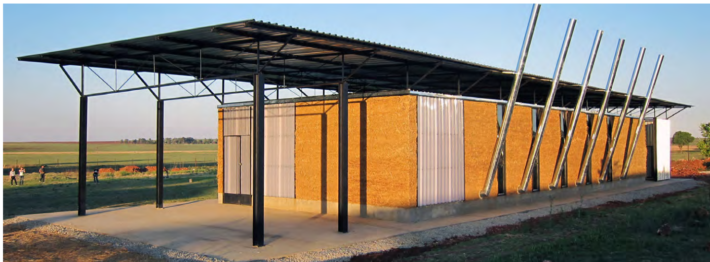
Slika 7: Večnamenska dvorana, 2011: pogled na zgrajeno stavbo z južne strani.
