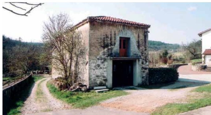
Slika 14: Matavun, Gombačeva ledenica. Kot ledenico so uporabljali prostor pod skednjem, vkopan v zemljo. Foto E. Belingar, 2002.
