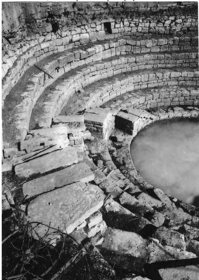
Slika 10: Kal pri Pivki – Kalska štirna. V ospredju so vidne kamnite stopnice, speljane po obodu štirne do dna. Foto: E.Belingar, 2004.
