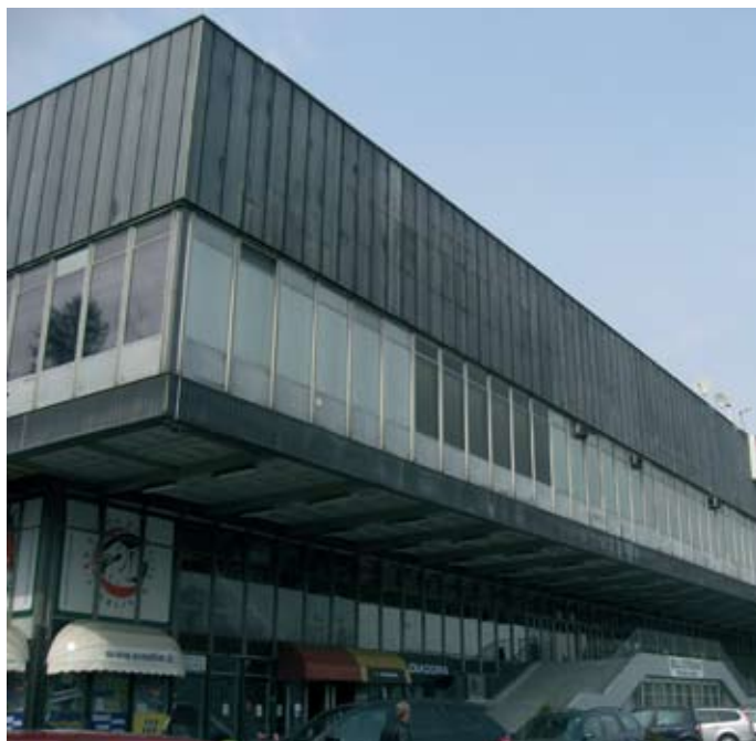
Slika 5: Marjan Božič. previsna jeklena konstrukcija Hale Tivoli v Ljubljani. Figure 5: Marjan Božič: Overhanging steel structure of Tivoli Hall in Ljubljana.
