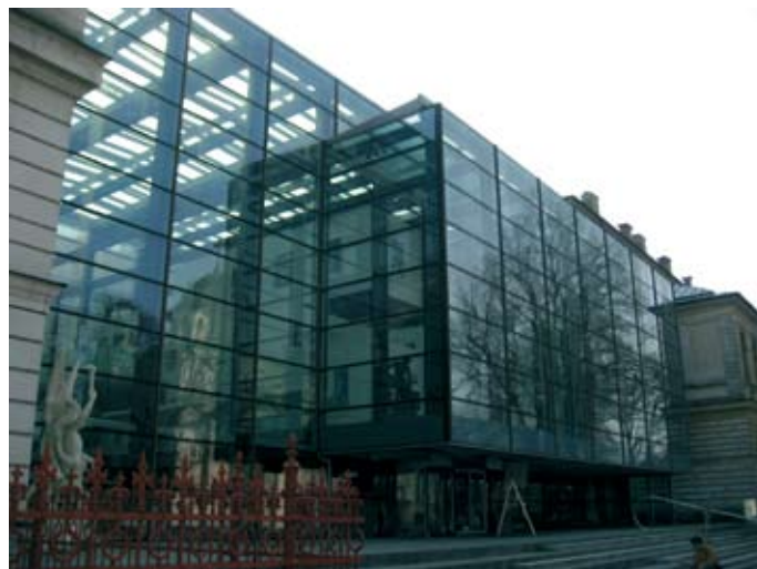
Slika 10: Sadar Vuga Arhitekti: jeklena konstrukcija osrednjega dela Narodne galerije v Ljubljani.
