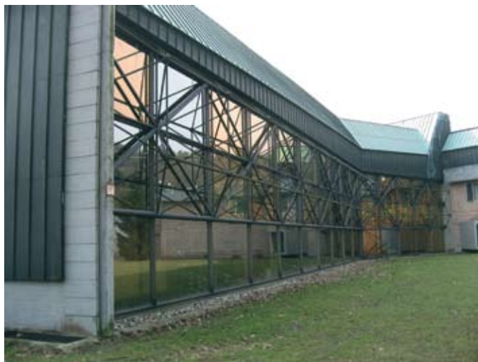
Slika 8: Fedja Košir: palična tridimenzionalna jeklena konstrukcija fasade Centralnega zimskega kopališča v Ljubljani.
